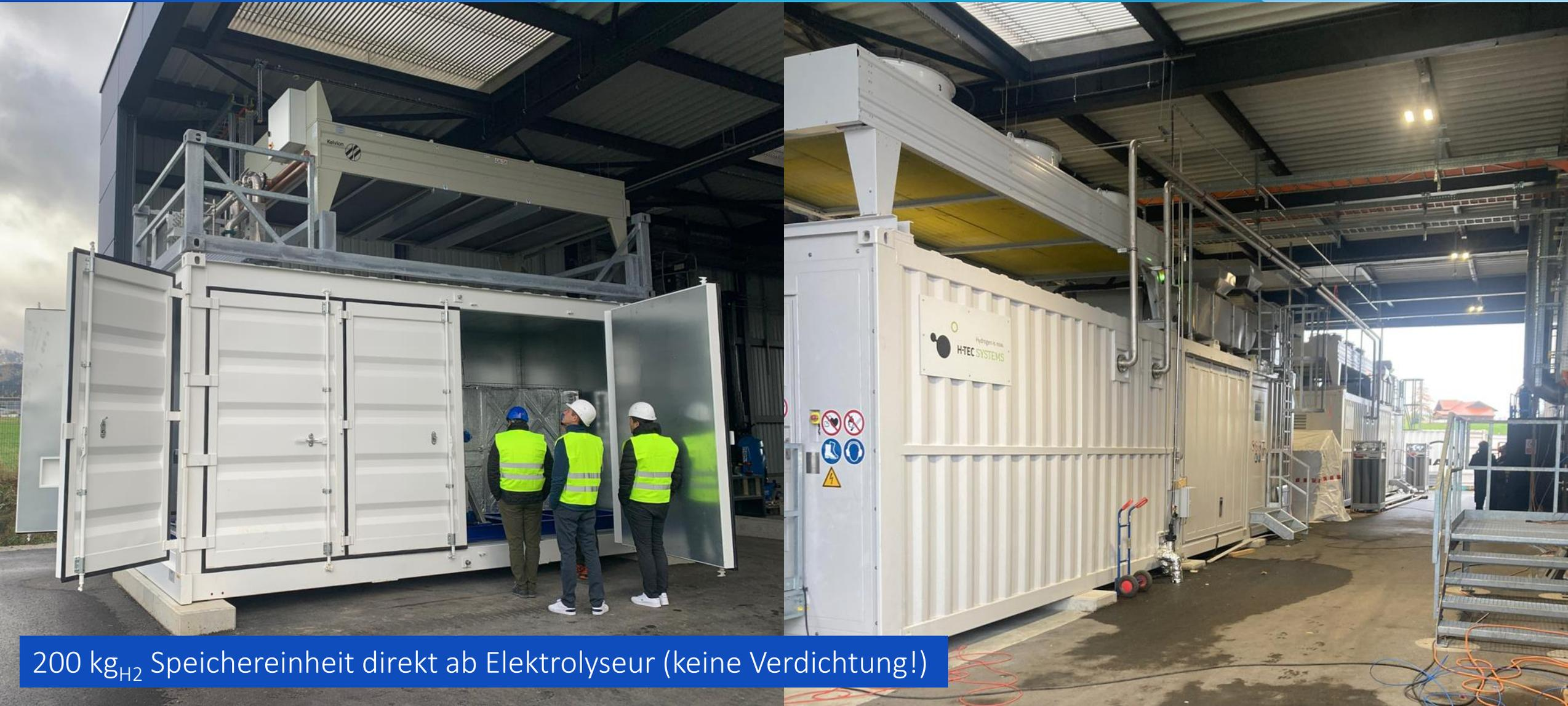
200 kg<sub>H<sub>2</sub></sub> Speichereinheit direkt ab Elektrolyseur (keine Verdichtung!)
